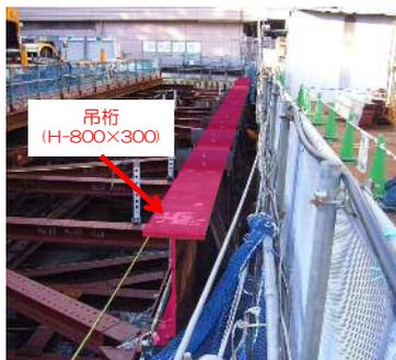
写真-2 吊桁設置後
