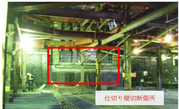
写真-3 仕切り壁切断後(当工事側より)
