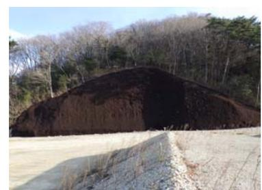
図-10 植生基材吹付け
