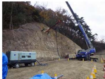
図-6 補強材削孔状況
