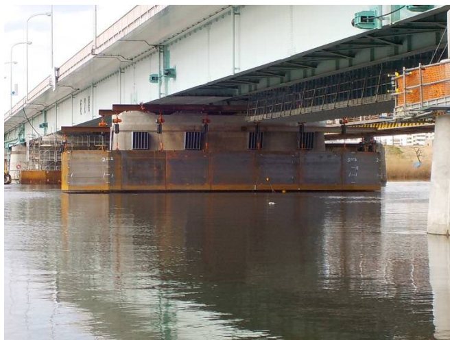
写真-1 鋼製パネル式仮締切り工法
