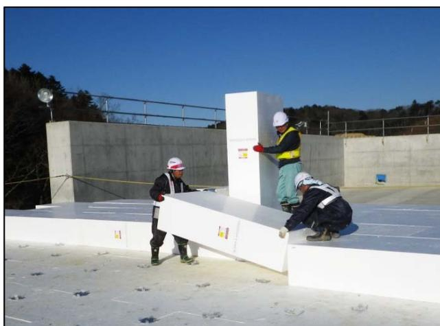
写真1 E P S施工状況
