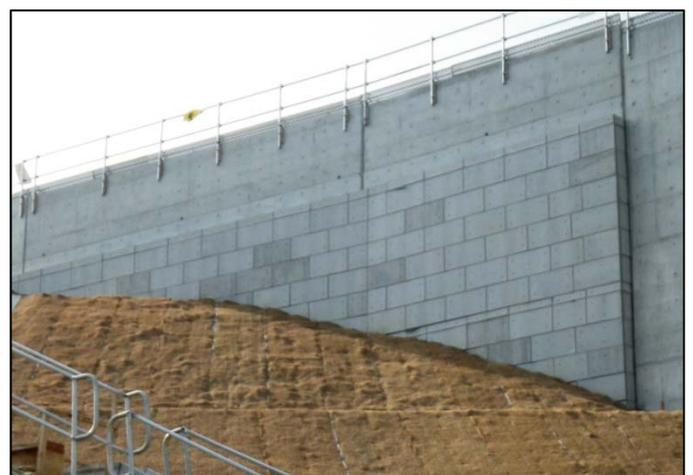
写真2 土留め擁壁工完成状況
