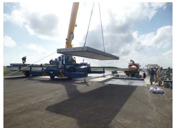
写真-5 PRC 版設置状況
