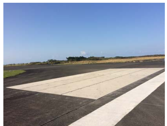
写真-7 PRC 版施工完了
