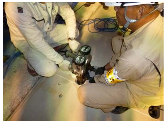
写真-6 コッター式継手ボルト本締め状況
