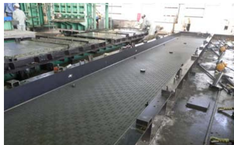
写真-4 鋼製型枠組立状況
