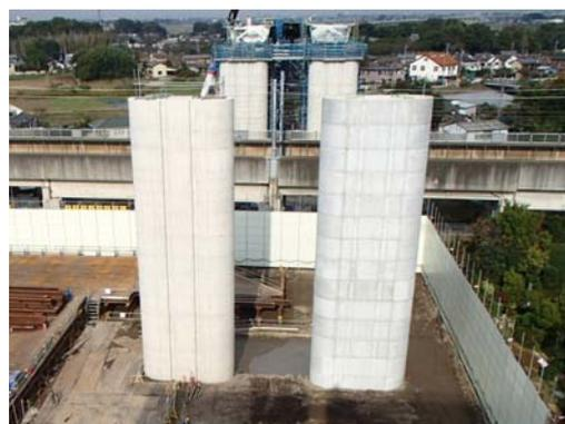
写真-4 構築完了（右側がハーフプレキャスト橋脚）
