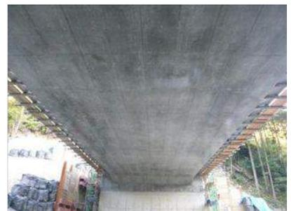
写真 - 3 PC 中空床版底面の仕上がり状況
