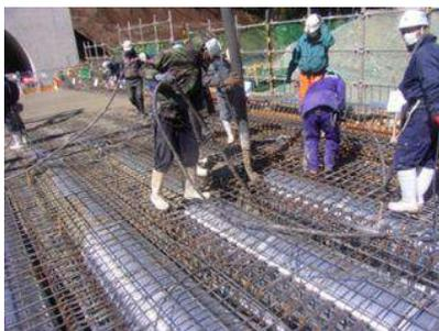
写真 - 1 PC 中空床版コンクリートの打設状況
