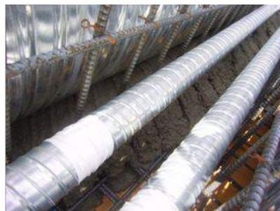
写真 - 2 円筒型枠下部へのコンクリートの充填状況
