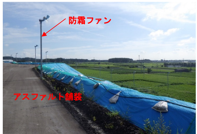
写真-2 防霜ファン、アスファルト舗装実施状況
