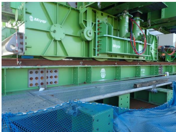
図-4 測定状況写真
