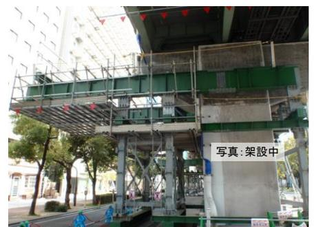
写真-1 支保工構築時
