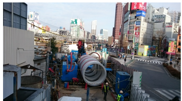
写真-1 東口作業ヤード
