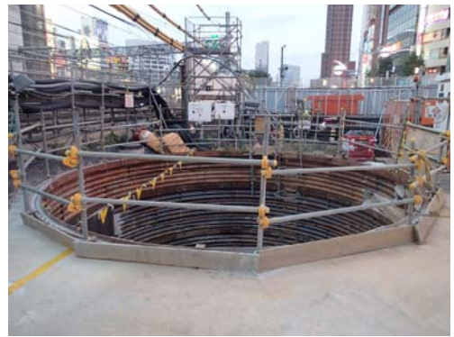
写真-2 立坑注意旗
