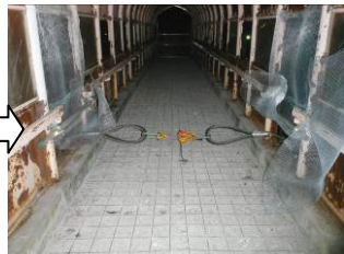
図-8 床版研り完了
