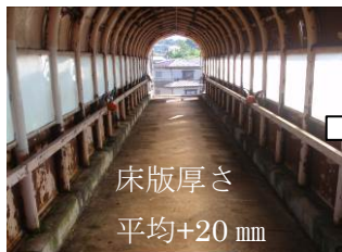
図-7 床版施工前
