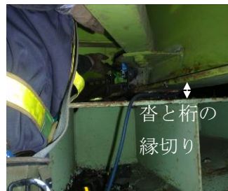
図-10 地切り状況
