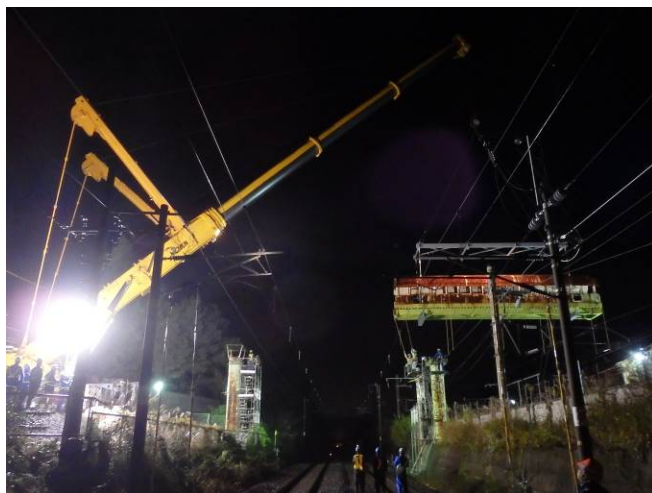
図-11 新幹線桁てっ去状況
