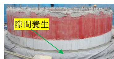
(b) 隙間養生後
