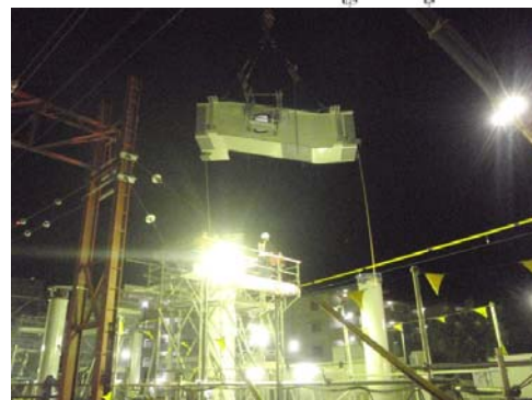
写真-1 特殊部材の架設状況
