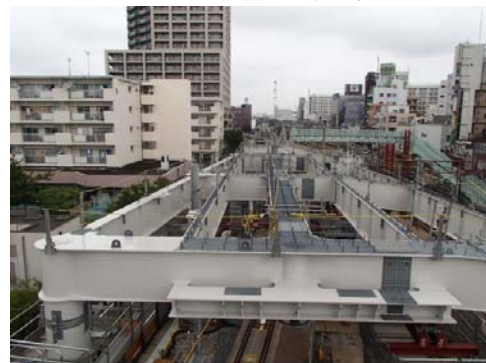
写真-2 架設・組立完了 (伊勢崎方向)
