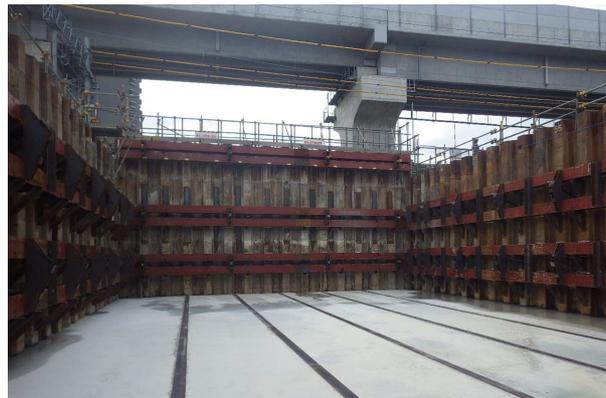
写真-3 発進立坑床付け完了
