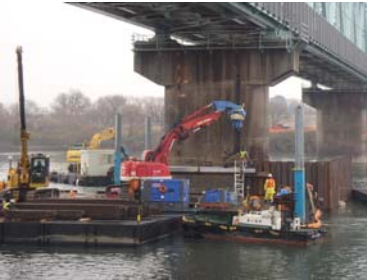
写真-2 鋼矢板打設写真
