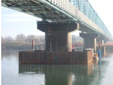
写真-3 鋼矢板打設完了写真
