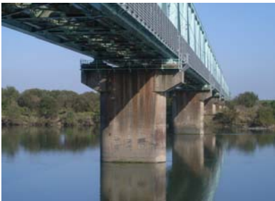
写真－1 対象橋りょう全景
