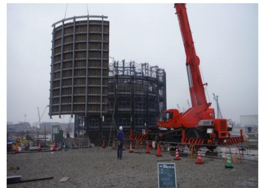
写真-4 ユニット型枠の揚重状況
