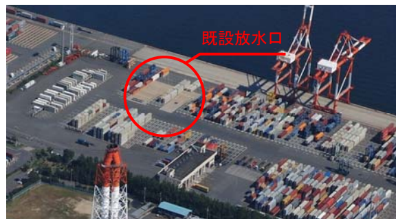
写真-1 着手前状況
