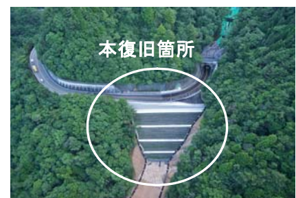
写真-6 本線盛土復旧完了全景
