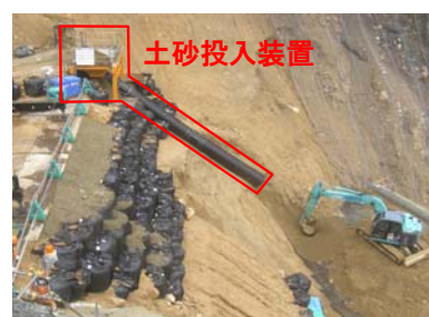
写真-5 土砂投入装置使用状況
