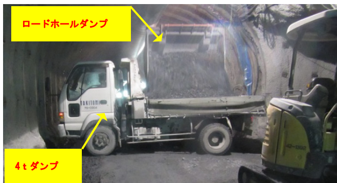
写真-1 ロードホールダンプによるズリ積み
