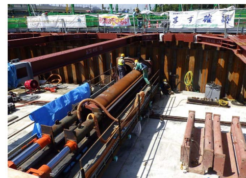
写真-2 施工状況
