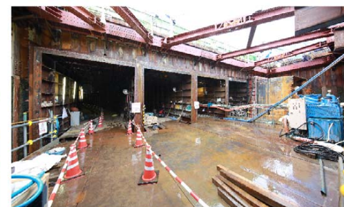
写真-3 5函体目到達時の全景
