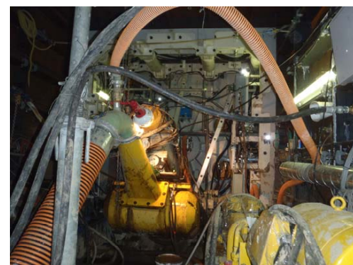
写真-2 推進状況(函体内)
