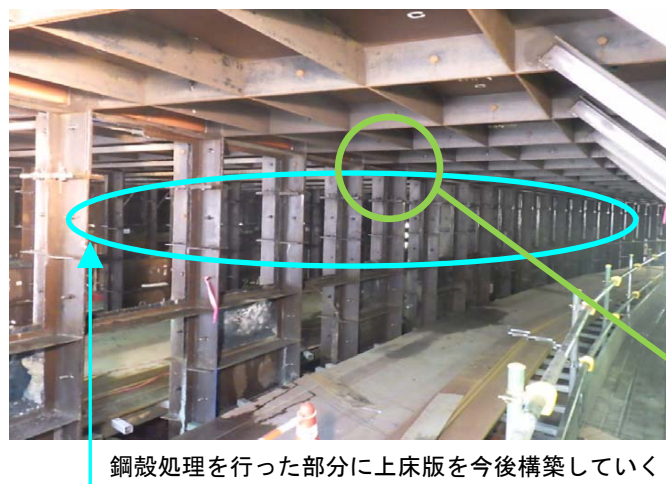
写真-4 上床版構築のための鋼殻処理状況
