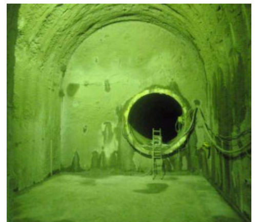
写真-1 トンネル拡幅完了全景
