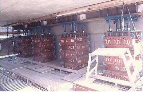
写真-1 ジャッキアップ状況
