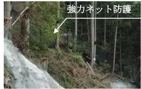
写真-1 強力ネット防護設置状況
