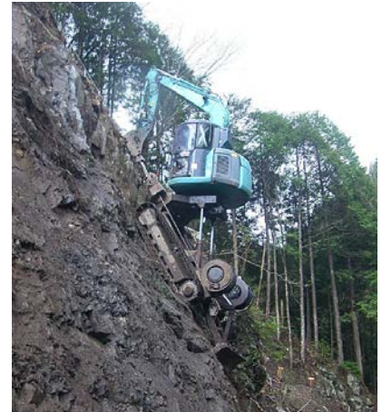
写真-2 ロッククライミング施工状況
