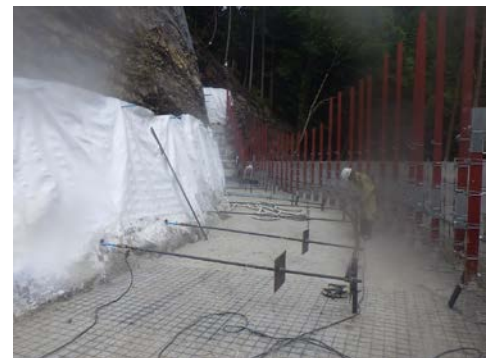
写真-2 FCB 盛土内の水平抵抗材設置状況
