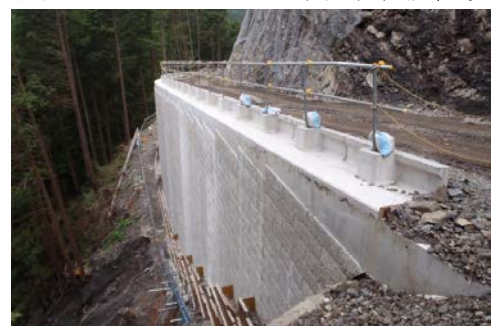
写真-3 FCB 盛土の完成状況
