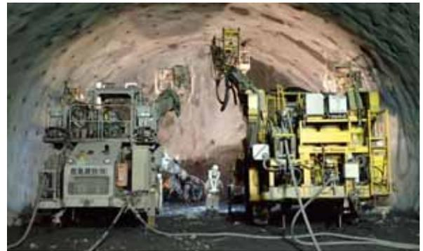
図-4 ジャンボ2台での削孔状況
