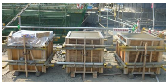
写真-1 大型供試体設置状況
