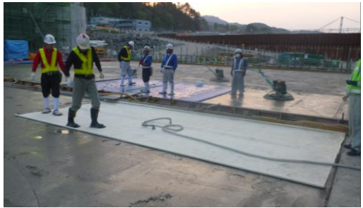
写真-3 真空脱水工法施工状況
