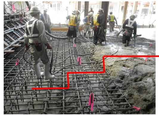
写真-1 「たわら打ち」の施工状況
