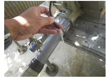
写真-2 注水設備設置状況
