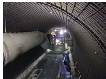
写真－1 配筋状況
