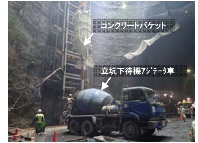
写真-2 実機試験状況
