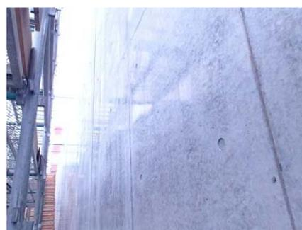
図-4 脱型後の躯体表面 (HF 配合)
