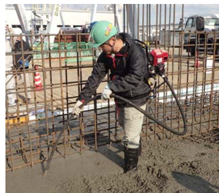
写真-1 エンジン式バイブレータの 施工状況
