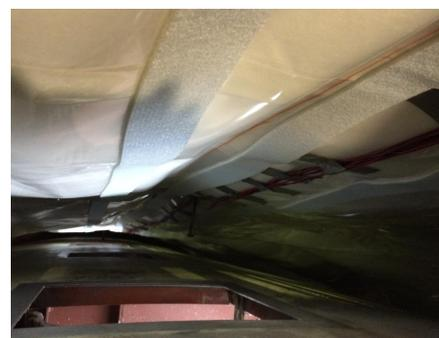
写真-2 不織布テープ工法の施工完了
