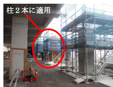
写真-1 柱部材の施工状況
