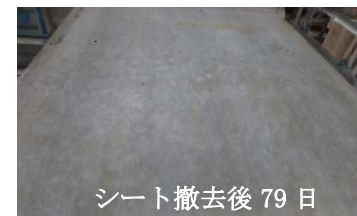
写真-3 シート撤去後
