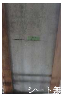
写真-2 シート有とシート無の外観
