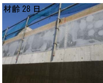
写真-9 シート養生状況
