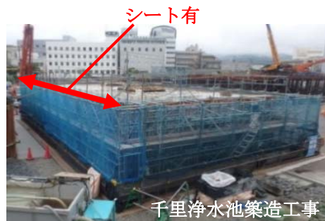
写真-7 シート養生適用箇所
