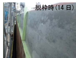
写真-8 シート養生の状況
