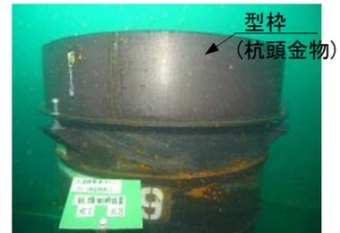
写真-3 杭頭金物設置状況
