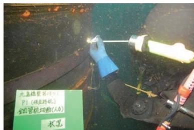
写真-2 水中ガス切断状況
