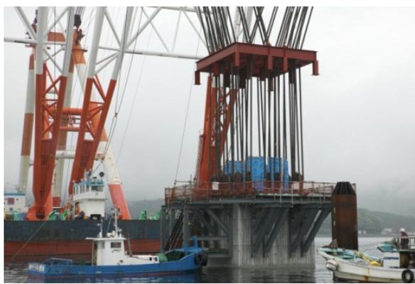
写真-5 橋脚据付状況
