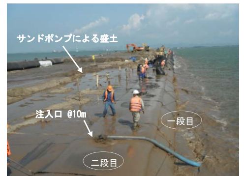
写真-3 二段目ジオチューブの充填
