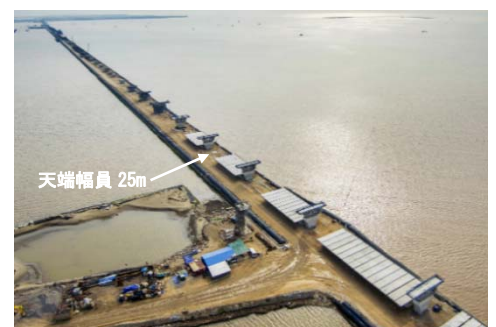
写真-4 ジオチューブに守られたアクセス
