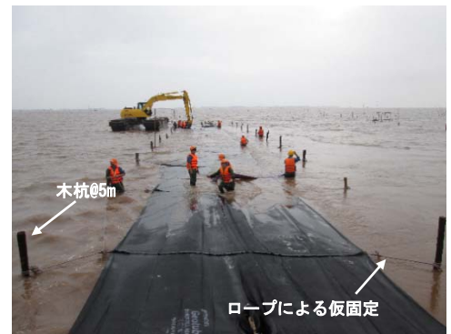
写真-2 一段目ジオチューブの布設
