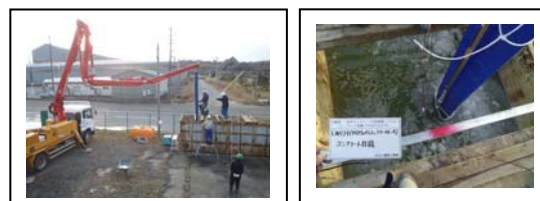
写真-2 水中CON打設品質性能試験状況
