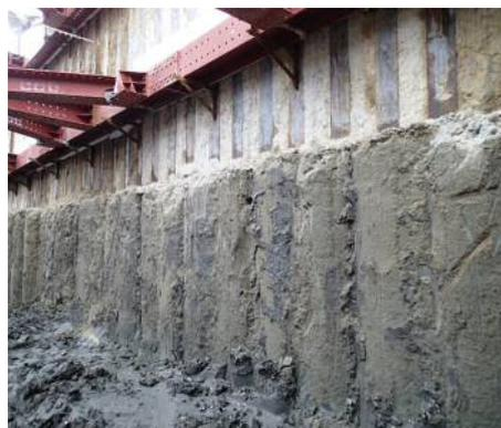
写真-2 先行削孔部の硬化状況
