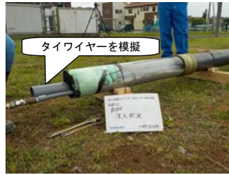
写真-3 中詰め材注入状況
