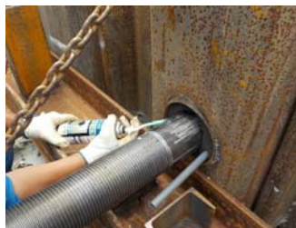
写真-7 ウレタン注入状況
