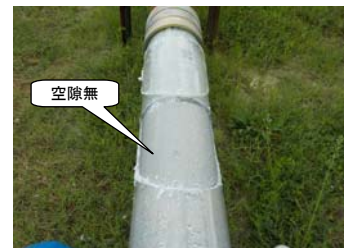
写真-11 充填状況
