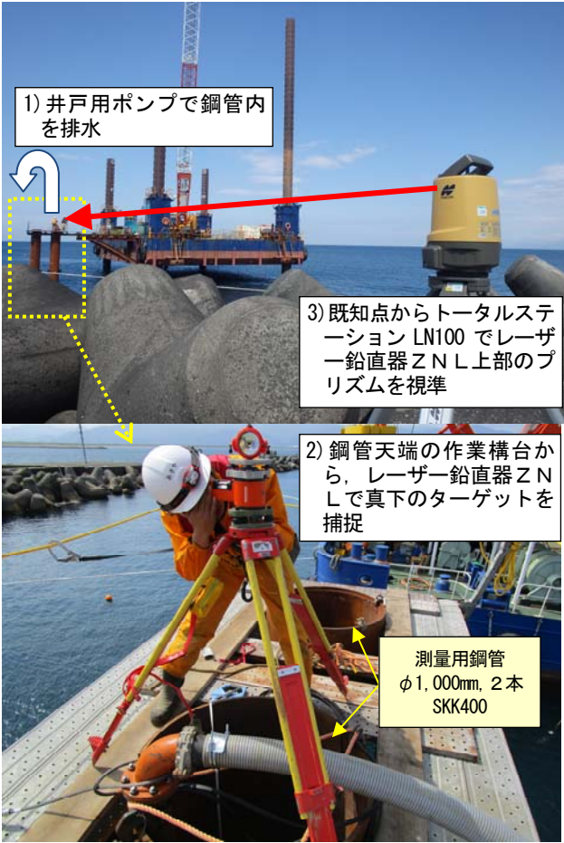
写真-3 直接視準による計測
