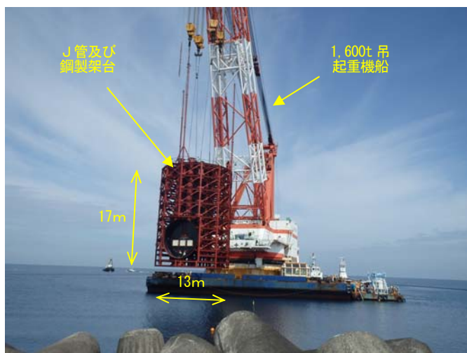
写真-1 J管の据付け
