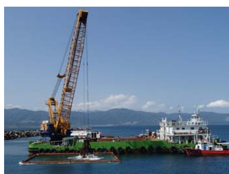
写真-4 井筒内の掘削
