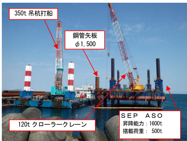
写真－1 鋼管矢板の打設状況
