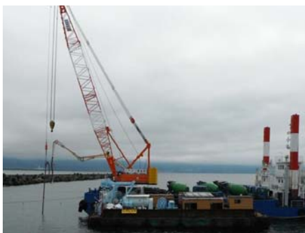
写真-3 間詰コンクリートの打設
