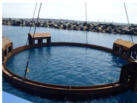
写真-2 支保工の設置
