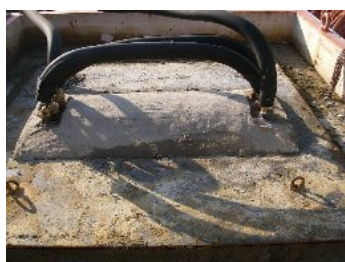
図 5 貼付凍結管(断熱前)
