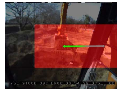
図-13 横溝埋め戻し
