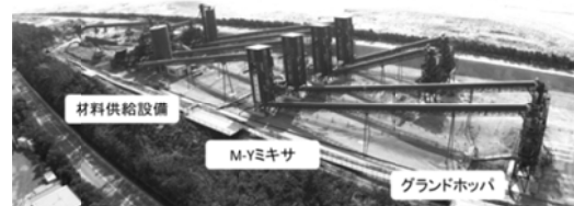
写真-1 浜松防潮堤 CSG 製造設備
