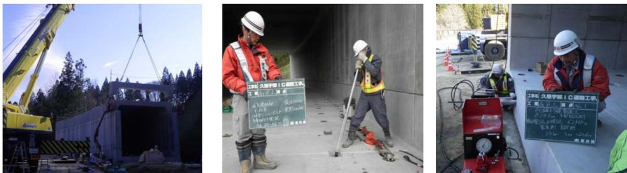
写真-2 施工状況(左より 部材据付 フランジ金具締付 PCより線緊張)
