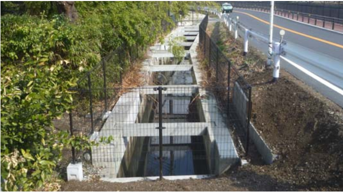
写真－2 改修後の水路
