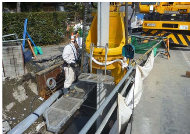
写真－4 パイラーによる矢板の圧入状況
