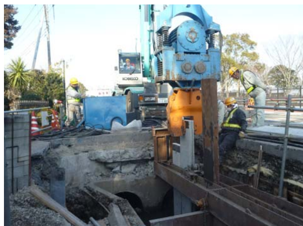
写真－3 バイブロによる反力矢板の打設状況
