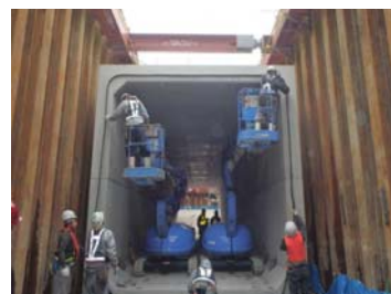
写真-3 止水板の設置状況
