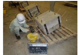
写真-1 性能確認試験(充填状況)
