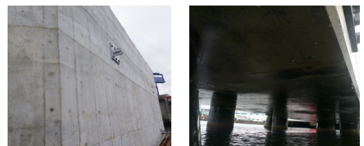
写真-4 型枠取外し後表面確認
