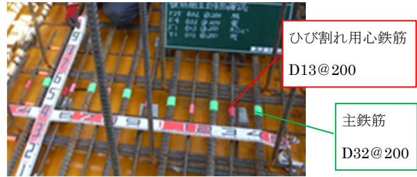
写真-3 ひび割れ用心鉄筋
